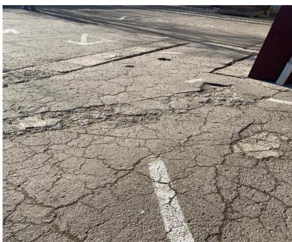
Înainte de renovare
