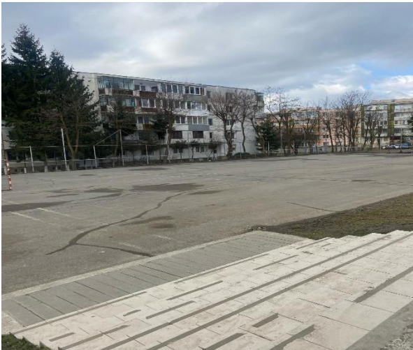
Înainte de renovare
