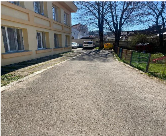
Înainte de renovare
