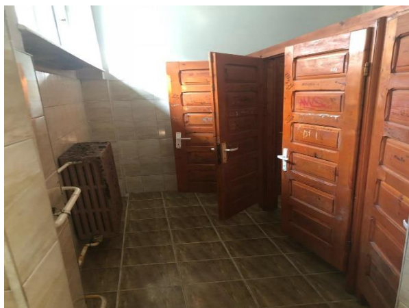
Înainte de renovare
