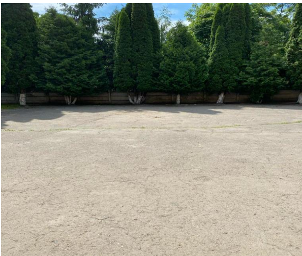
Înainte de renovare
