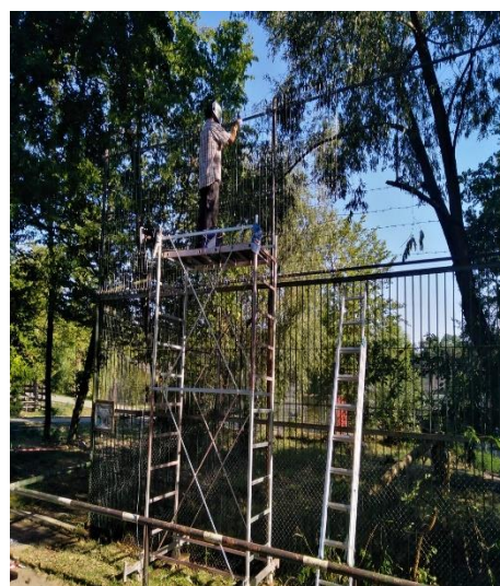
Foto: Lucrări de sudură electrică -Padoc exterior tigrii
