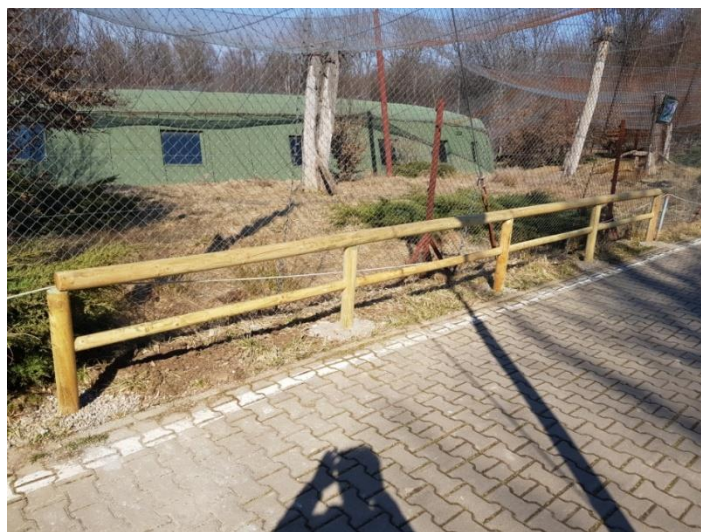
Foto: Balustrada lemn la padocul exterior al pavilionului de felin
