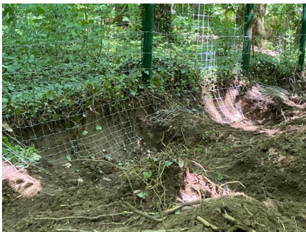
Foto: pregătirea terenului pentru prelungirea gardului de sârmă la adâncimea de 50 cm sub nivelul solului
