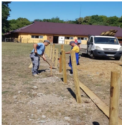
Foto: construcție gard-padocul exterior al grajdului de animale domestice
