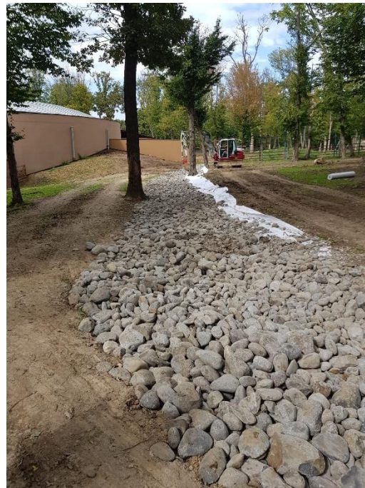
Foto: Padoc exterior aferent pavilionului de elefanți și girafe-recompartimentare și drenaj
