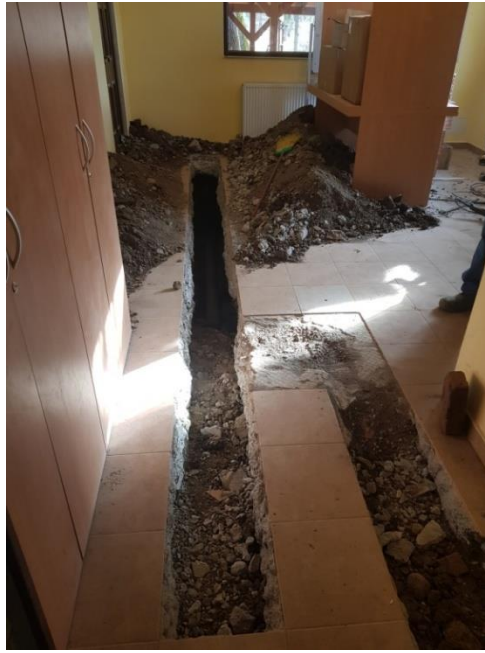
Foto: schimbarea rețelei de canalizare interne- clădirea administrativă
