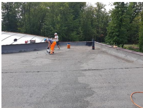
Foto: acoperișul nou izolat al pavilionului de elefanți și girafe
