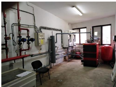
Foto: Sala de cazane pavilionul elefanți și girafe-centrala termică nouă
