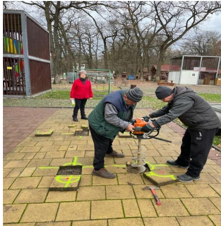
Foto: montarea meselor de tenis în locul special amenajat prin turnarea de beton la picioarele acestora la Platoul Cornești
