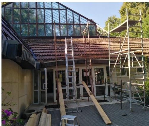
Foto: lucrări de renovare-casa maimuțelor
