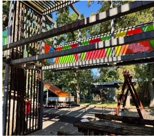
Foto: înlocuirea podelei la complexul de joacă din Parcul de la Platoul Cornești
