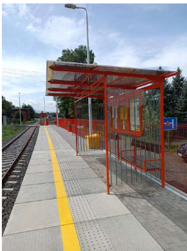
Figura 3-29 - Stația Proszówka (Sursa: Google Earth)
