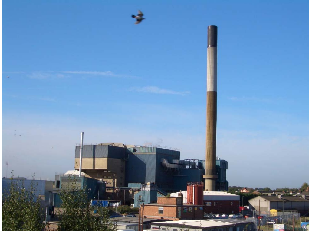
Instalație de incinerare a deșeurilor menajere
