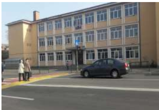
Înainte de renovare
