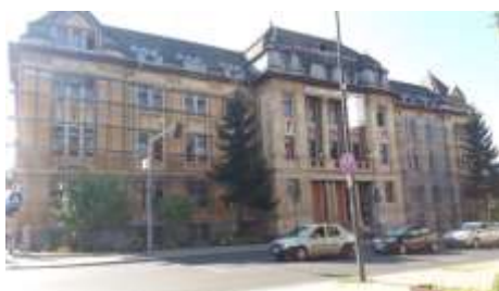
Înainte de renovare
