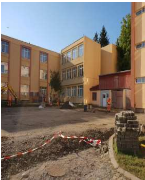
Înainte de renovare
