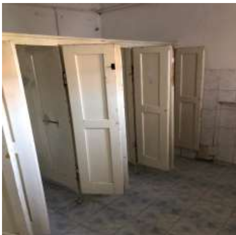
Înainte de renovare
