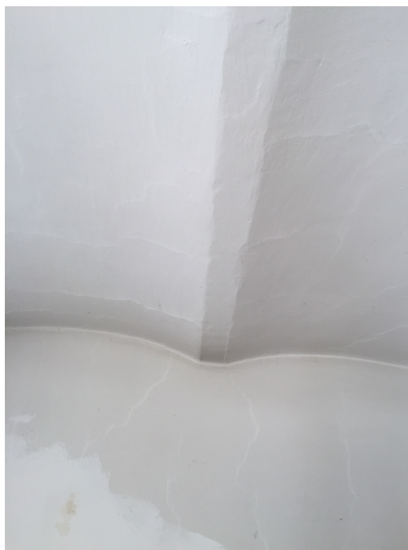
Boltisoare de caramida pe profile metalice
