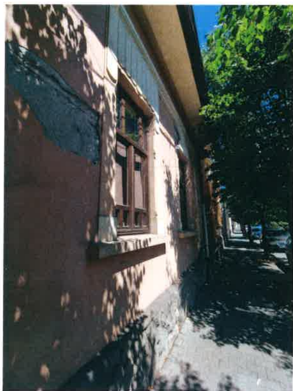
Fațada principală, partea stângă cu zona degradărilor nestructurale – desprinderi de tencuială.
