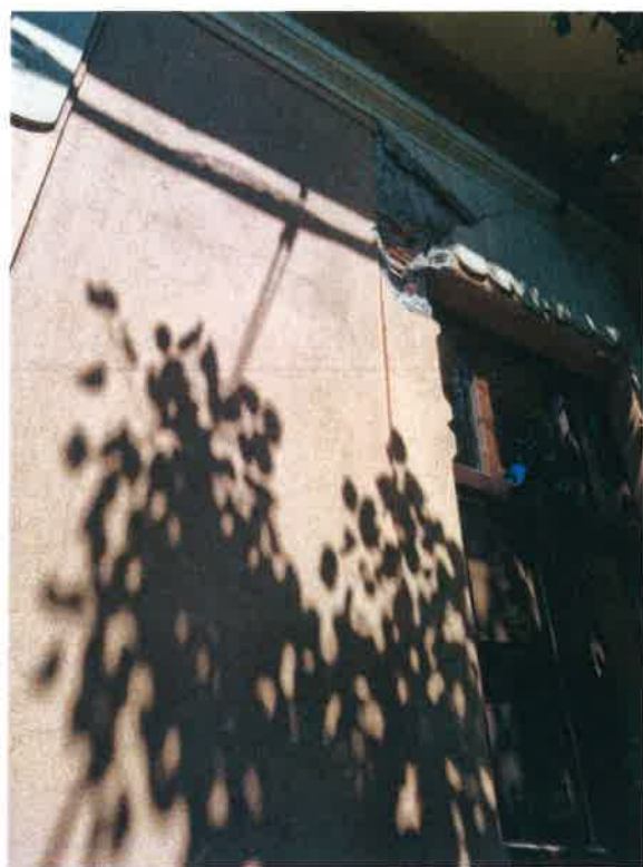
Fațada principală, partea stângă cu zona degradărilor nestructurale – desprinderi de tencuială.
