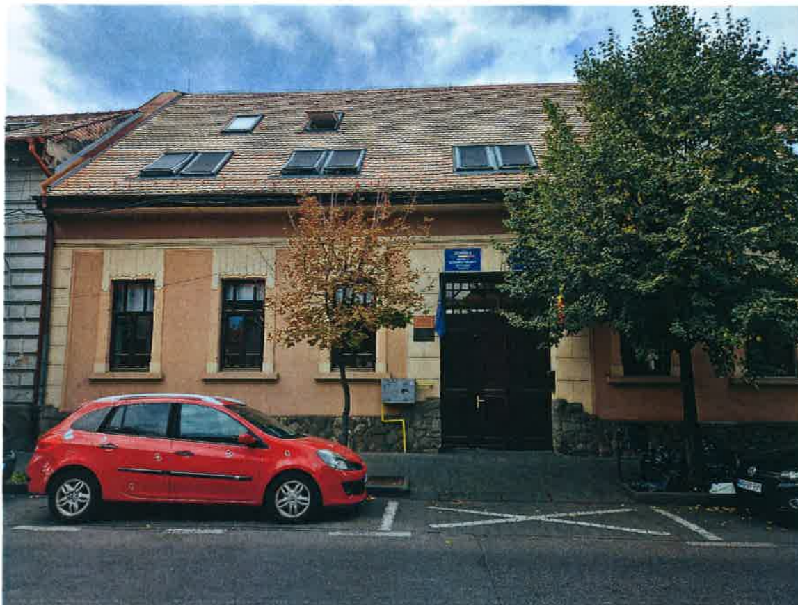
Fațada principală, partea dreaptă
