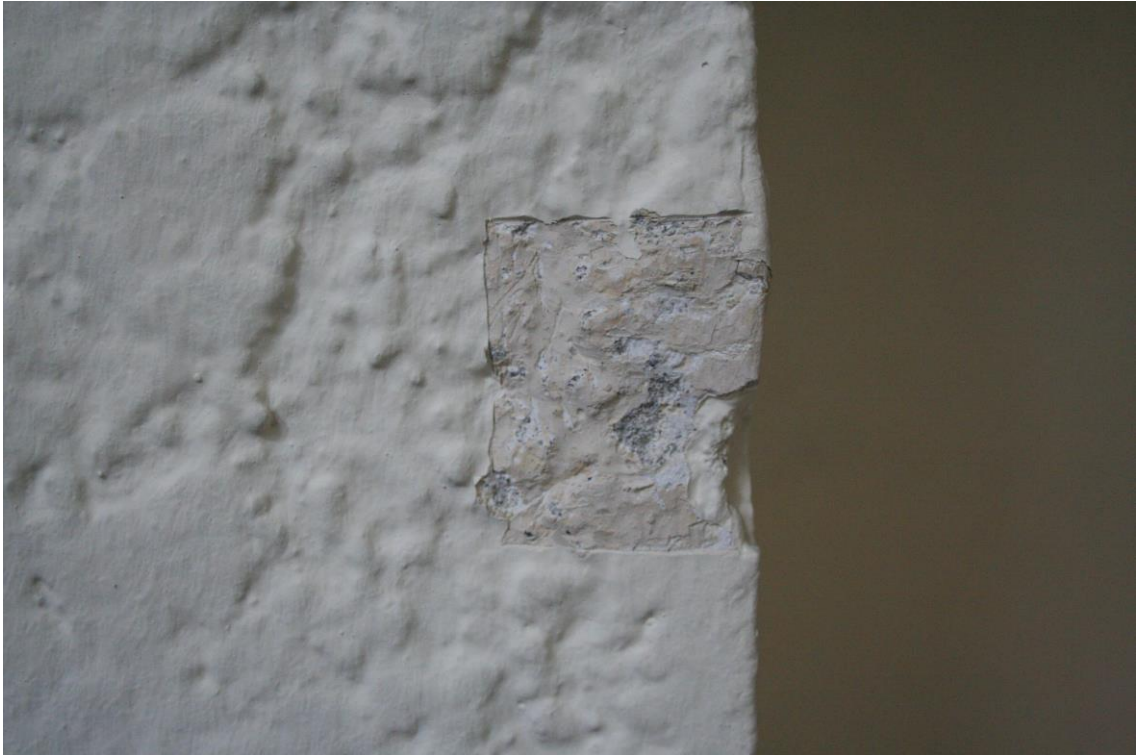
Sala de ședință: sondaj stratigrafic.
