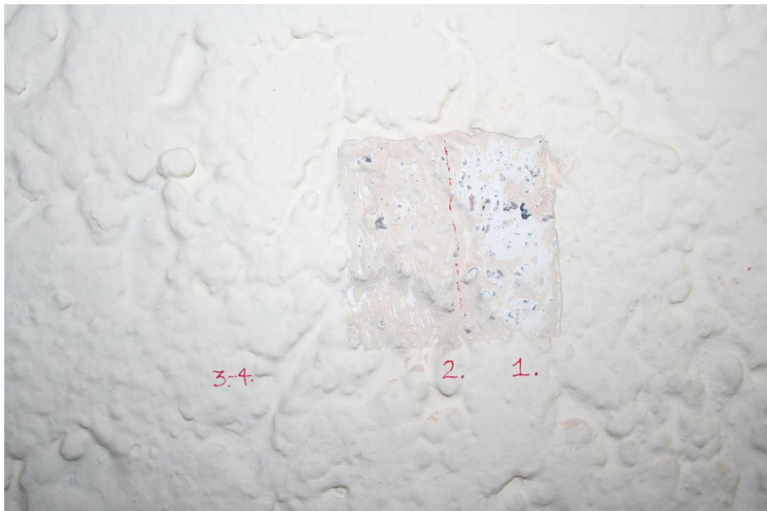
Sala de ședință: sondaj stratigrafic.
