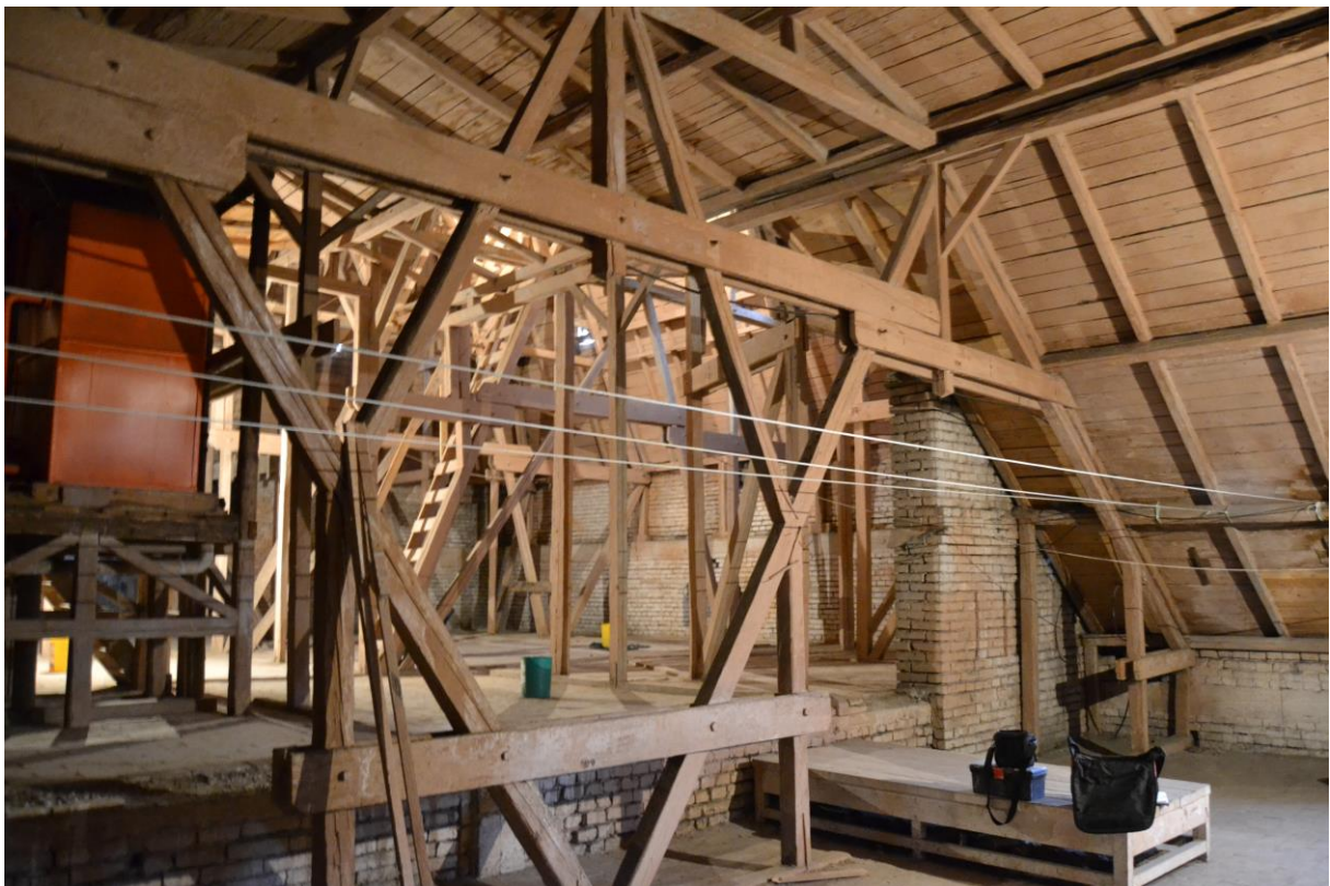
Pod, structura șarpantei.
