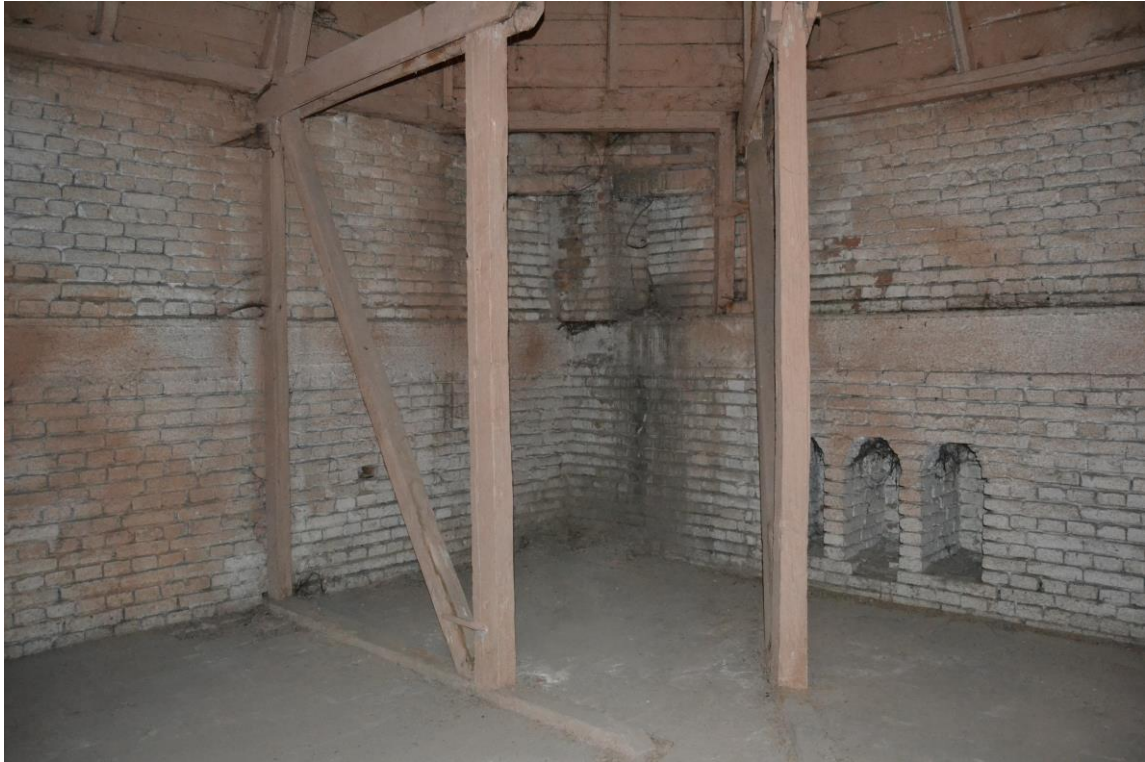
Pod Zidăria de cărămidă și coronamentul din beton armat. Cele trei nișe sunt elemente ale fațadei care nu au fost realizate sau ulterior au fost modificate.
