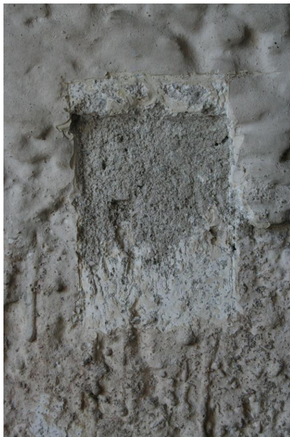
Sala de ședință: sondaj stratigrafic.
